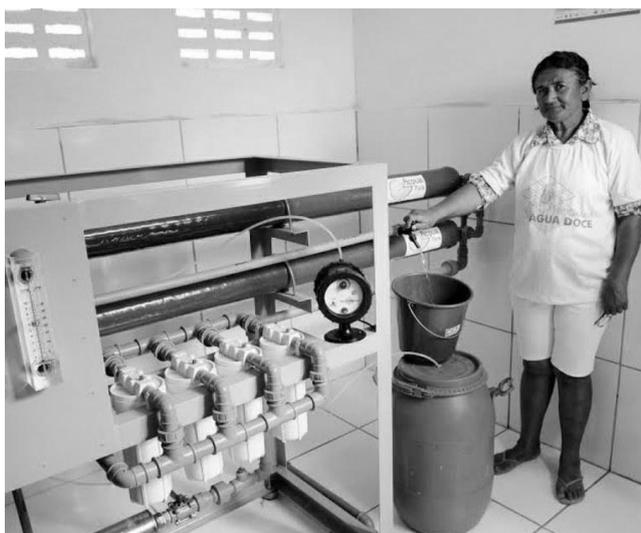
**Figura 2.4** Sistema de dessalinização do Programa Água Doce no estado da Paraíba. Fonte: PAD (2014).
