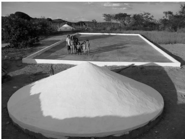
**Figura 2.3** Cisterna calçada no Semiárido paraibano. Fonte: ASA (2017).
